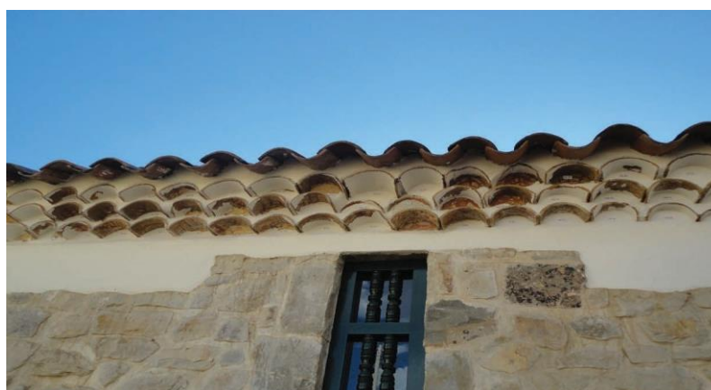
Fig. 15. Adaraja del baptisterio, cubierta con pintura vinílica blanca durante las labores de restauración del templo en 2007. Foto del 2012: cortesía de Nérida Aucahuasi Dongo.
