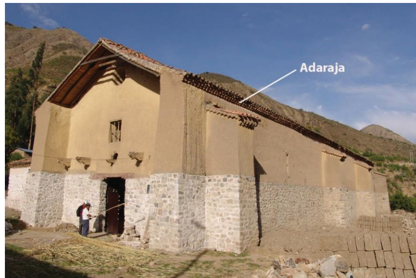
Fig. 13. Fachada y muro lateral del templo colonial de San Pedro de Chuquinga, con las adarajas debajo de las bocatejas. Año 2006. Foto cortesía Ciro Palomino.
