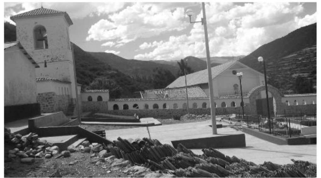
El templo colonial de Chuquinga restaurado al 30 de noviembre del 2007
