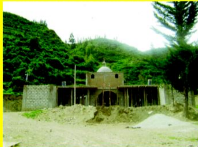
Santuario Señor de Ánimas en construcción
