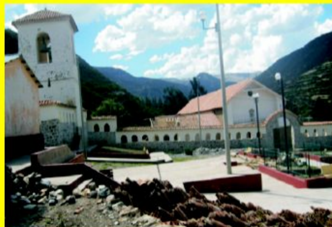
Restauración del Templo Colonial de Chuquianga
