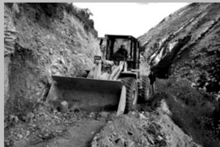
Apoyo con maquinaria pesada para la limpieza del Tramo Carrozable de Challhuanca a Huarquiza
